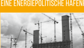
Baustelle des Kohlekraftwerks Moorburg Foto: Anti Atom Büro Hamburg
